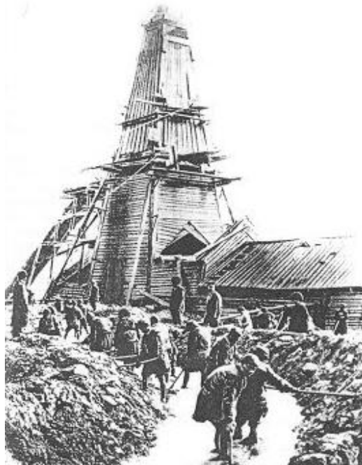
Рисунок 2. Земляные работы у фонтанирующей скважины.
