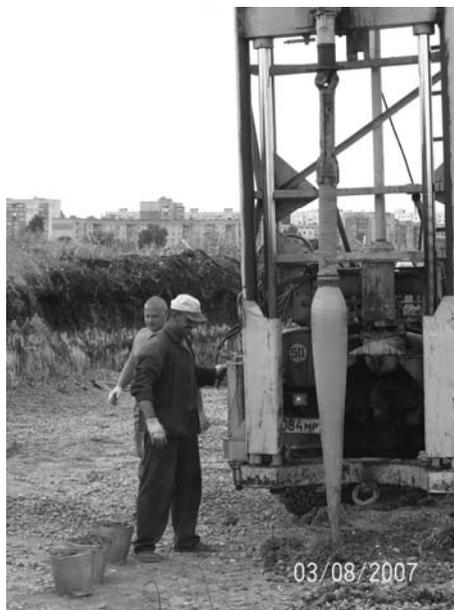
Рис.Ф.14.61 (начало). Раскатчики различной конструкции:
