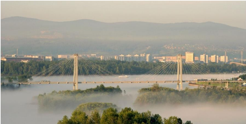
Рисунок 7.4 – Вантовый мост в г. Красноярске
