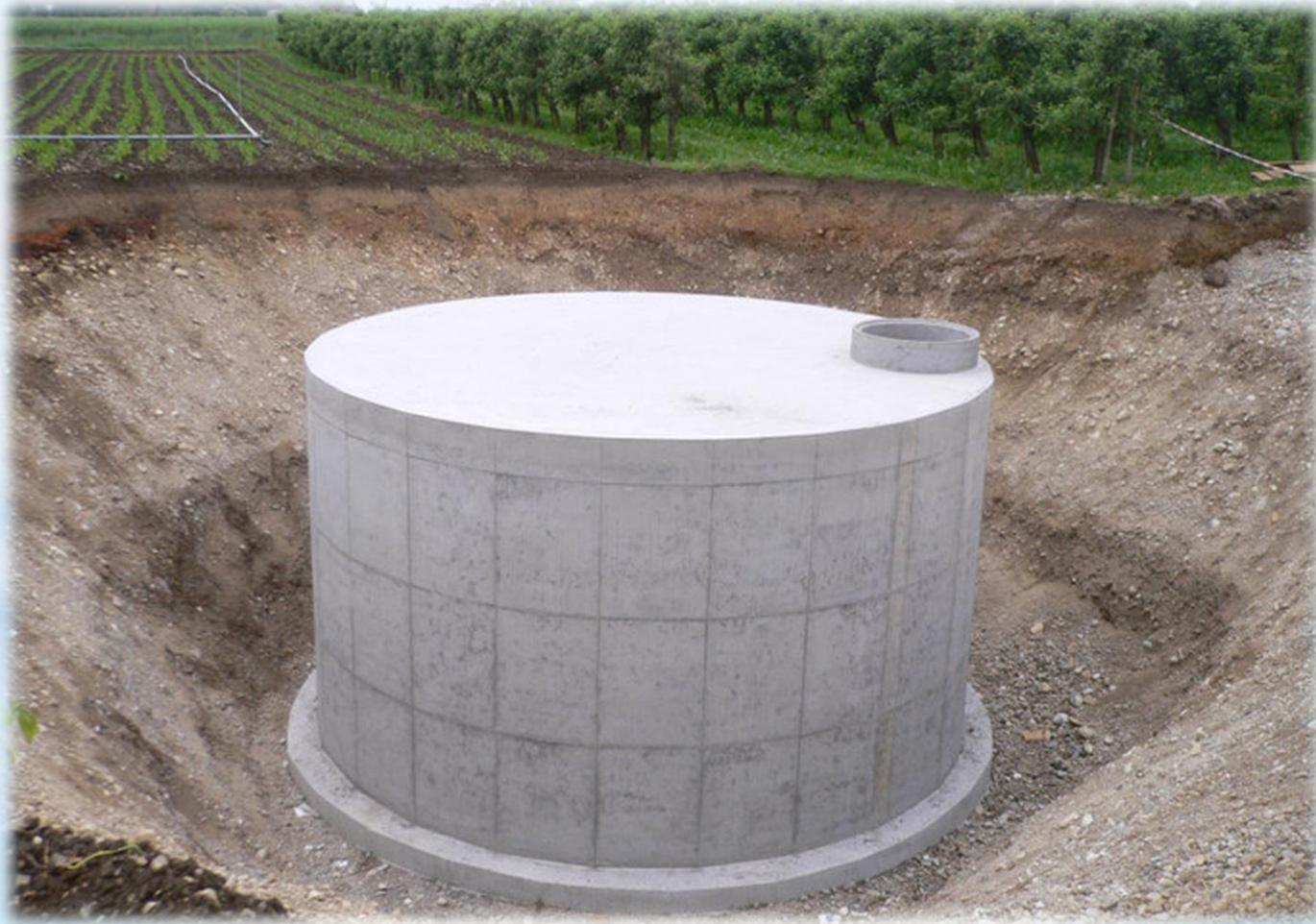
Предназначены для хранения воды, технологических растворов, газов, нефти и нефтепродуктов.
