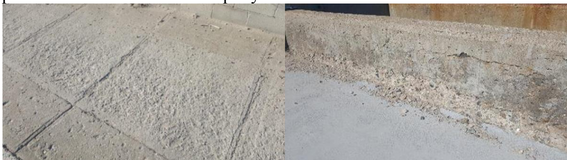
Рисунок 2 - Влияние процессов замерзания и оттаивания в бетоне
