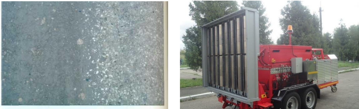
Рисунок 1 – а) шов при инфракрасном нагревании однородный; б) оборудование для нагрева покрытия дороги инфракрасным излучением
