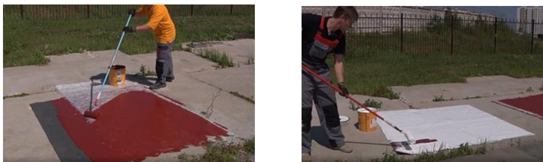
Рисунок 4- Технология работ жидкой резиной (этап 3-4).
