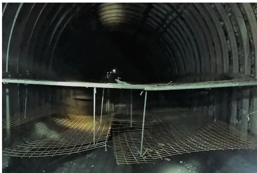
Рис. 2. Армирование искусственной потолочины
