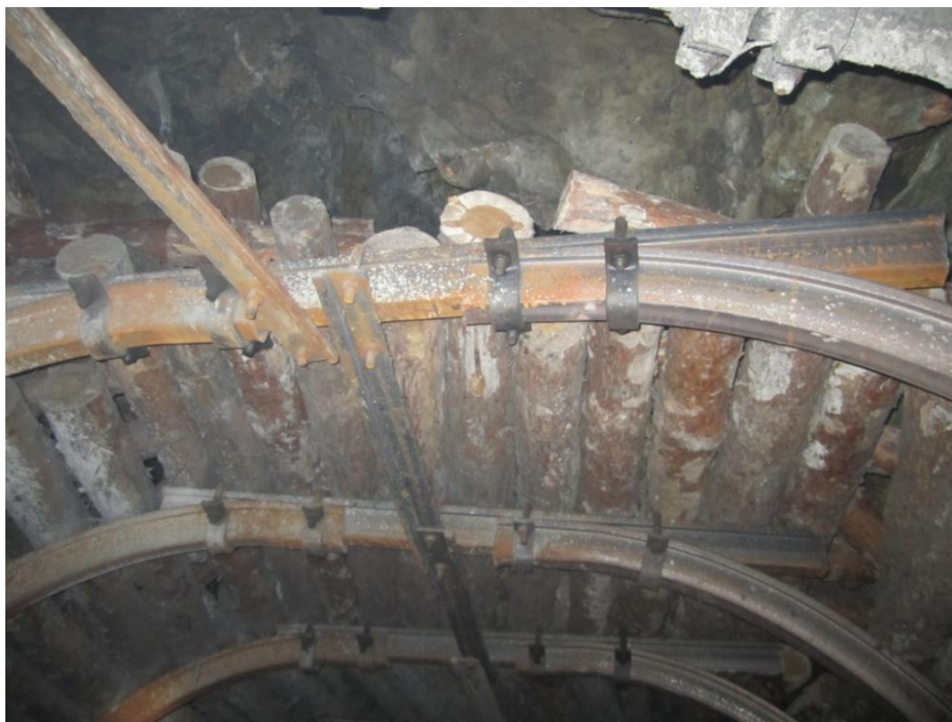
Рис. 1.1. "Купол" на Артемьевской шахте на отм. -153 м
