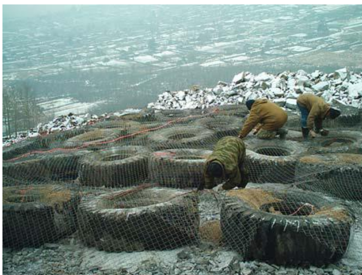
Рис. 1.2. Монтаж укрытия с сеткой «Рабица»
