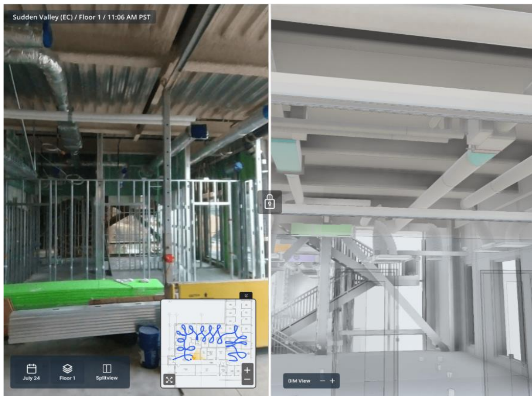
Рисунок 2 - Захват реальности на строительном объекте с использованием робота
